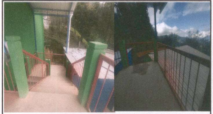
Foto 8: Mantenimiento a barandas de metal 50 M2
