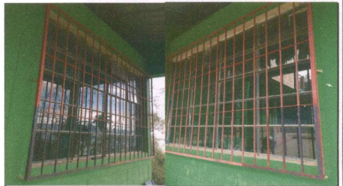
Foto 4: Mantenimiento a balcones de metal 50 ML
