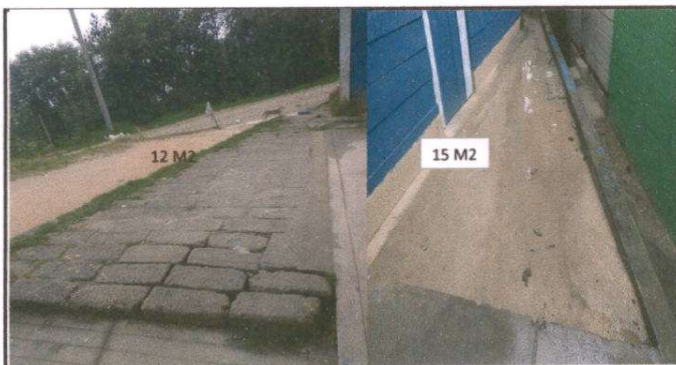
Foto 11: Losa de patio 27 M2
