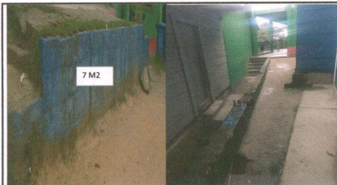
Foto 9: Reparación de muro perimetral de block. 22 M2
