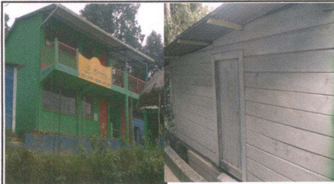
Foto 7: Pintura en muros exteriores e interiores 600 M
