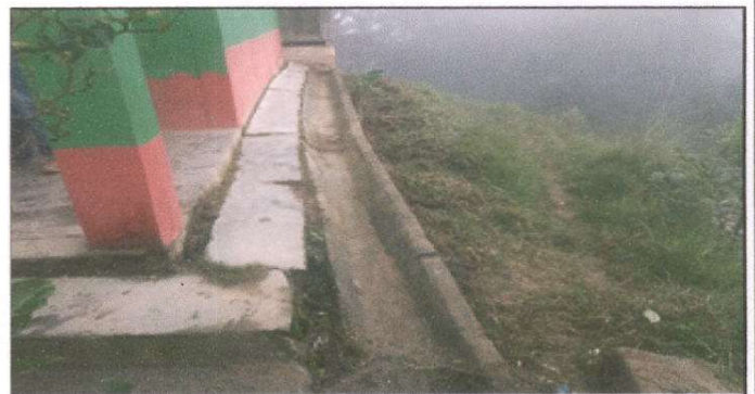
Foto 6 Reparación de banquetas de concreto y cunetas 16 M2
